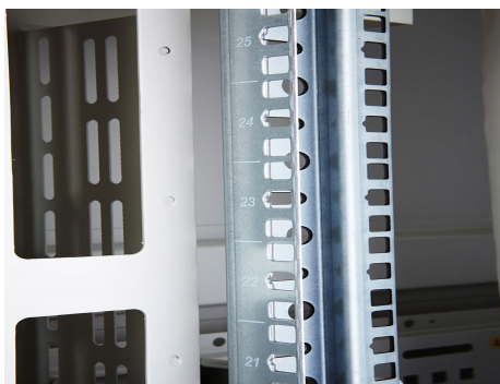
Perfiles de 19" marcados con posición de altura U
