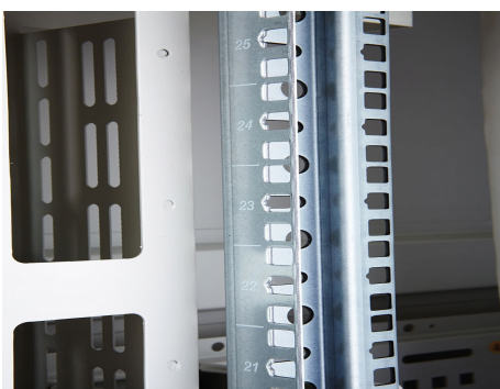
Montants 19 pouces avec incrémentation des U
